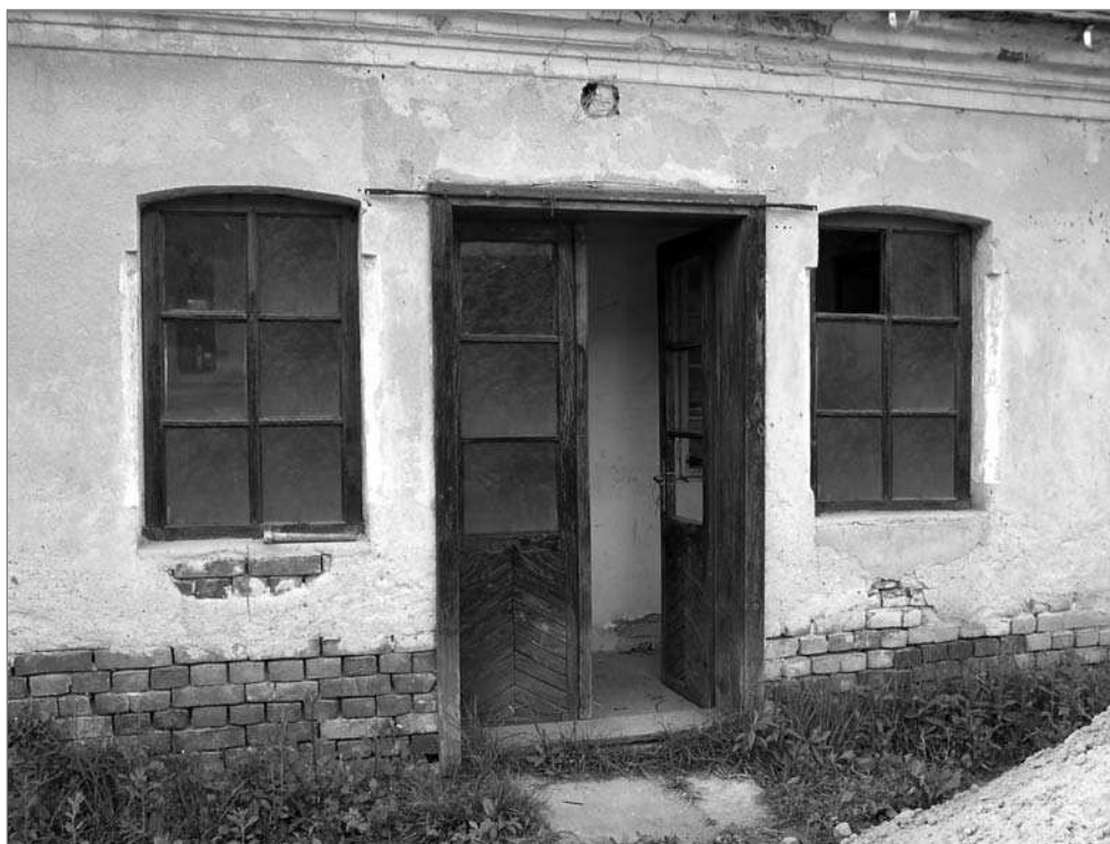
3. kép: A pitvar nyílásaiba beépített ablakok és ajtó (amatőr felvétel, 2003.)
