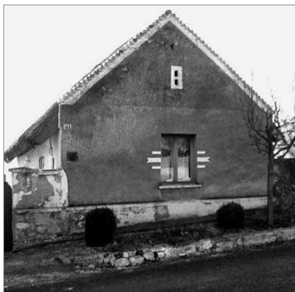
13. kép: A ház homlokzata (fotó: Petánovics Katalin)
