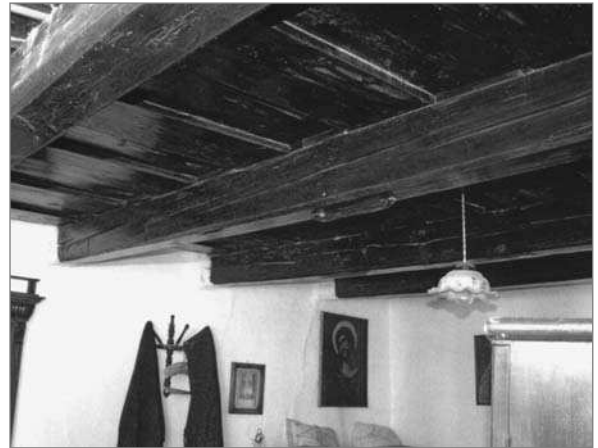
10. kép: A szoba deszkaborítású gerendás mennyezete (fotó: Balassa M. Iván)
